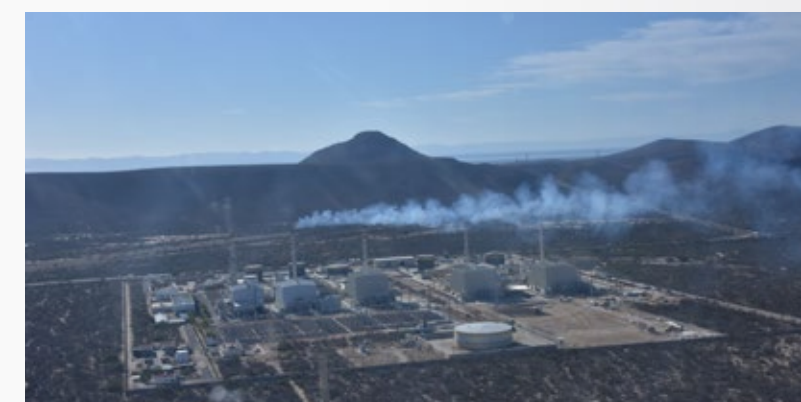
Central de Combustión Interna Baja California Sur V. Diciembre 2016.
