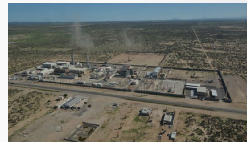
Central de Combustión Interna Guerrero Negro III. Diciembre 2016.
